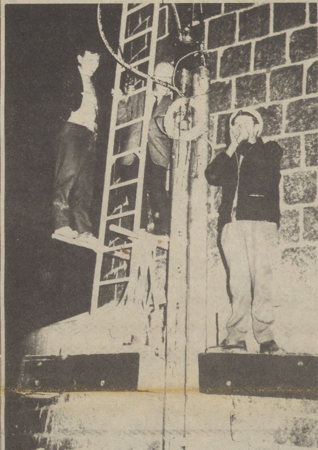
Dette natbillede er taget under broklappen ved Limfjorden, da man stoppede for sejladsen og installerede gasledningen, som her går ned under sejlrenden. Foto: Bent Madsen.
